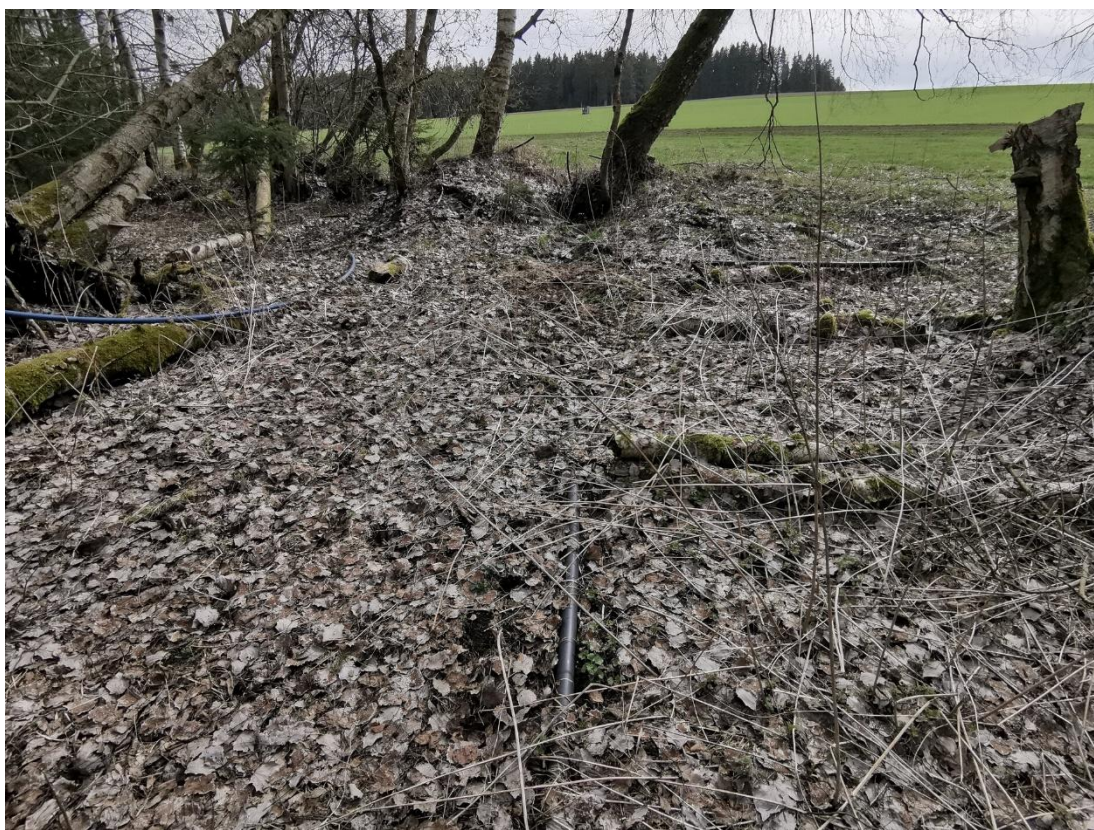
Obrázek 17 Tier2_MuehlbacherWaldung_07.jpg – Potrubní vedení na horní části svahu cíleně odvádějí přitékající vodu kolem tělesa rašeliniště k prostředním rybníkům.
