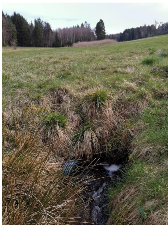
Obrázek 12 Tier2_MuehlbacherWaldung_02.jpg – Vyústění drenáže v dolní luční části
