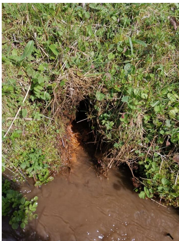
Obrázek 6 Tier2_Heiligenwiese_02.jpg – vyústění drenáže
